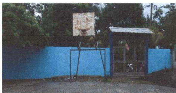
Foto 4: Pintura en muros interiores en muro perimetral
