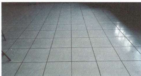
Foto 3: Sustitución de piso de cemento por piso cerámico en módulo 1
