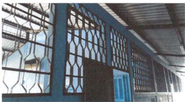
Foto 1: Mantenimiento a balcones de metal del módulo 1 parte de enfrente
