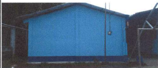
Foto 5: Pintura en muros exteriores en módulo 2
